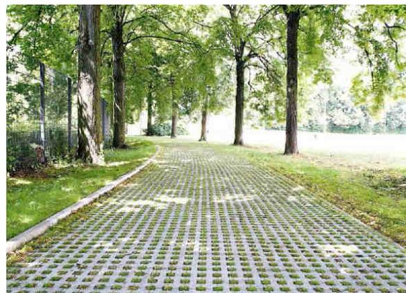
Exemple d'allée réalisée en revêtement alvéolaire engazonné. Source: Pays de Gâtines – Parthenay
